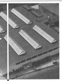
Kittlose Oberlichter für Shed- Sattel- und Pultdächer Parallelöffnende Ventilations-
