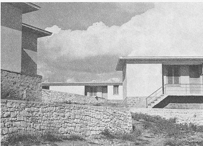
Doppelwohnhäuser für Arbeiter in Agrinion. Arch. Skiadaressis
