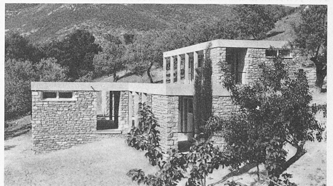
Garderobehaus für die Schauspieler des Theaters von Epidaurus. Beton und Naturstein. Arch. A. Konstantinidis
