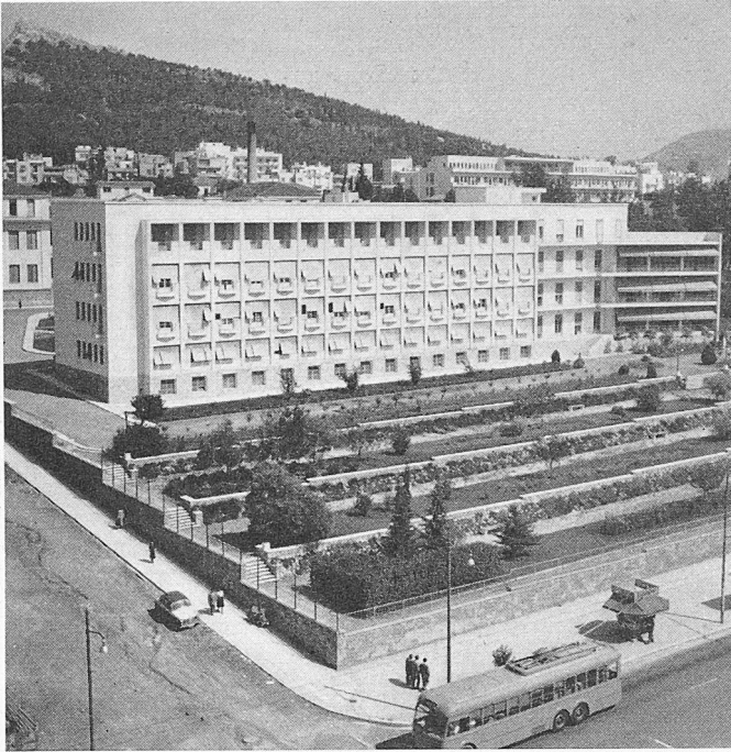
Militärspital in Athen, Architekt Biris
