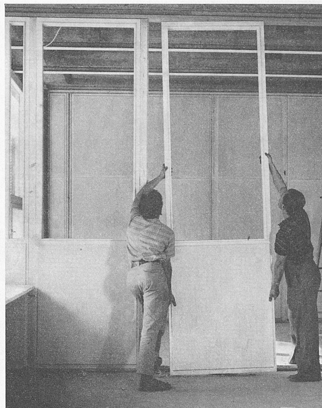
Aufstellen der demontablen Zwischenwände
