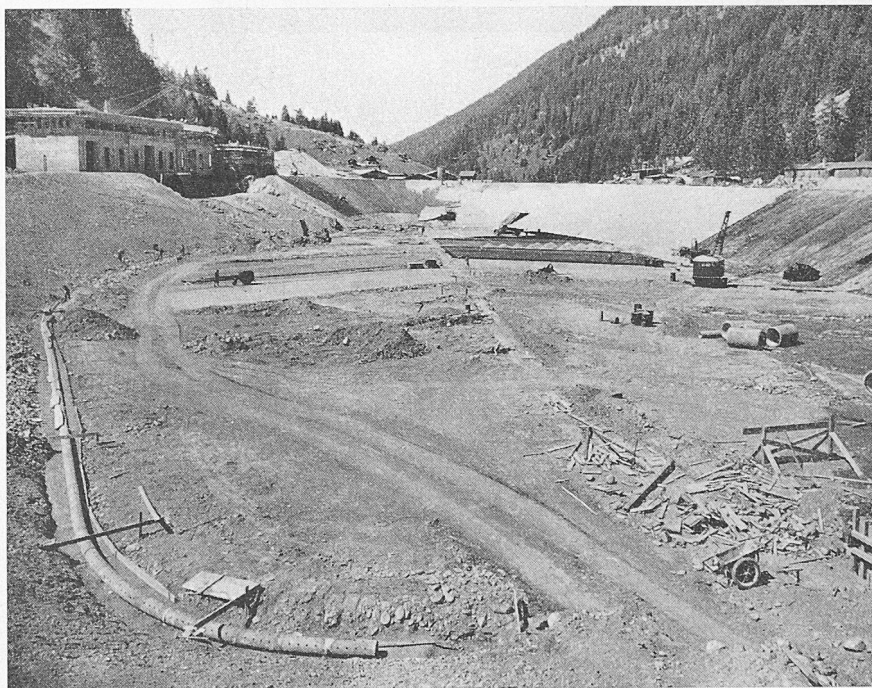
Bild 2. Ausgleichbecken Motec der Gougra-Kraftwerke. Uebersicht der Baustelle mit Entwässerungssystem
