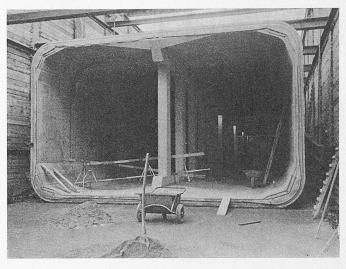
Bild 19. Zweigleisiges Tunnelfertigteil in Spannbeton
