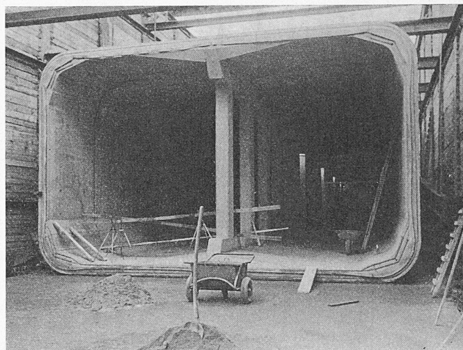
Bild 19. Zweigleisiges Tunnelfertigteil in Spannbeton
