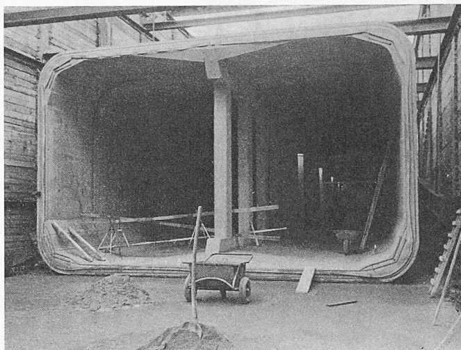
Bild 19. Zweigleisiges Tunnelfertigteil in Spannbeton
