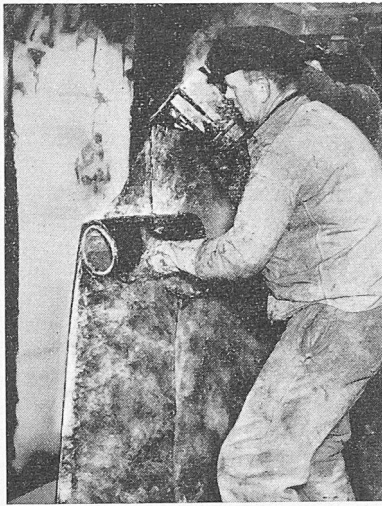
Bild 6. Aussenisolierung im Giess- und Einwalzverfahren
