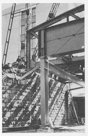
Bild 11. Hauptträgerende auf Pendelstütze
