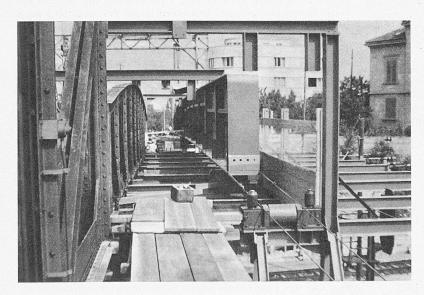
Bild 9. Längseinschieben eines Hauptträgers neben der alten Brücke
