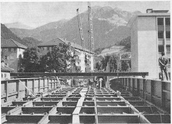
Bild 10. Blick auf den Fahrbahnrost nach erfolgter Montage, Hinten letzter Rest der alten Brücke vor dem Abbrechen
