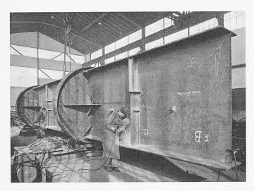
Bild 8. Schweissen eines Hauptträgerstückes mittelst Drehvorrichtung
