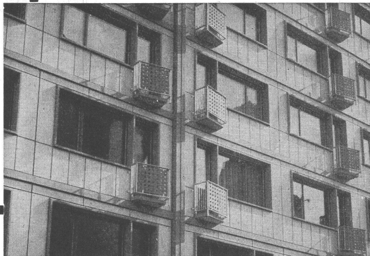
Ausfachung eines Beton-Skeletthaues
