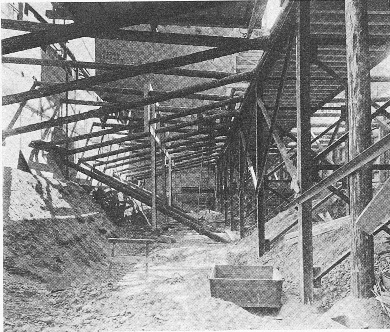
Bild 12. Spriessung der Kellerwand gegen die Aeschenvorstadt nach Ausführung der 2. Etappe.
