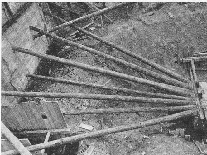
Bild 18. Neubau Neue Warenhaus A.G. in La Chaux-de-Fonds. Abspiessung einer Schmalseite der Baugrube gegen ein Fundament
