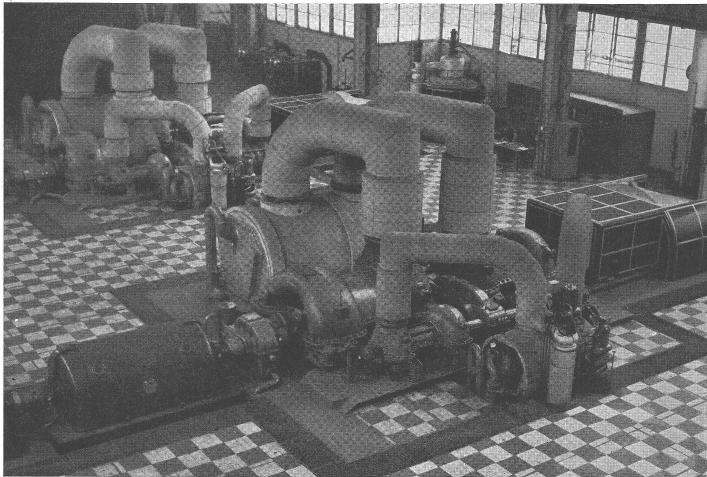
Das Bild zeigt zwei Sulzer-Gasturbinengruppen von je 7500 kW, die im Werk Couillet der Société Métallurgique Hainaut-Sambre (Belgien) aufgestellt sind. Sie dienen zum Antrieb elektrischer Generatoren und Hochofengebläsen und haben rund 28 000 Betriebsstunden hinter sich. Bei den im Jahre 1957 von einer neutralen Expertenkommission durchgeföhrten Abnahmemessungen wurden folgende Leistungen und Wirkungsgrade gemessen (in Klammern = Garantiewerte):
