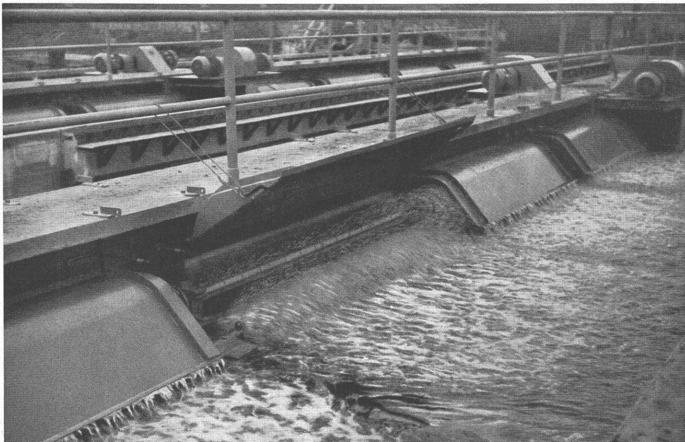
**Belebtschlammmanlage nach T.N.O.-Passavant für hohe Raumbelastungen**
