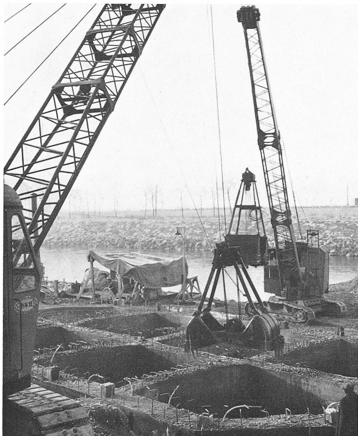
Senkkasten Strompfeiler Seite Oesterreich im Absenken begriffen
