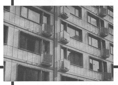
Ausfachung eines Beton-Skelettbaues
