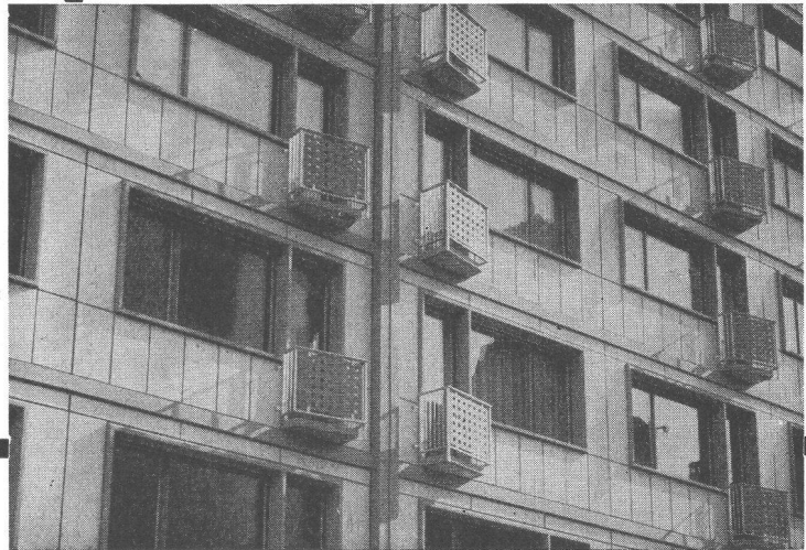
Ausfachung eines Beton-Skelettbau
