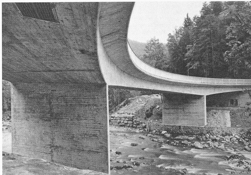
Bilder 1 (oben) und 2. Ansichten der Finsterseebrücke
