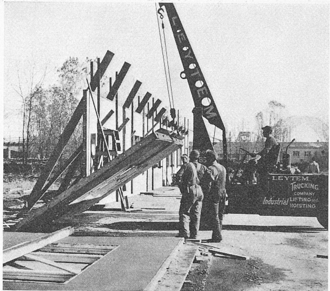
Bild 3. Tilt-Up-Konstruktion. Man beachte die drei Phasen: Betonieren am Boden, Aufklappen und provisorisches Verstreben in der Endlage. Photo Portland Cement Association, Los Angeles, California
