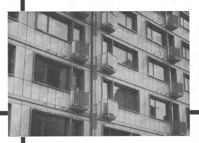
Ausfachung eines Beton-Skelettbaues
