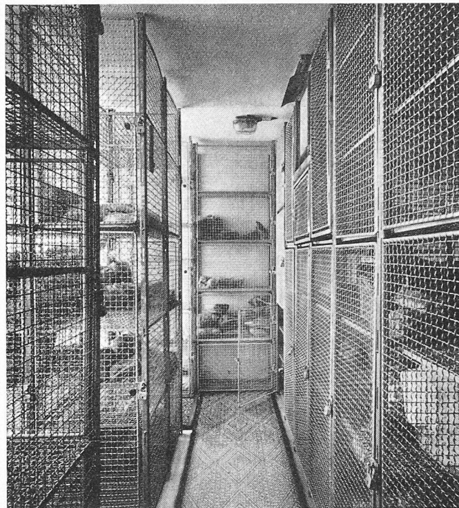
Bild 2 Kaltraum mit Füchern aus verzinkten Eisenteilen
