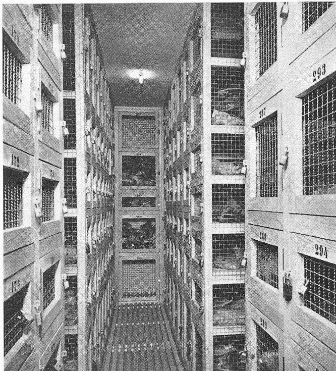
Bild 1 Kaltraum mit Holzfüchern für -18/-20^{\circ}\text{C}
