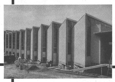
Eisenbetonbau, vollständig mit PORA-Platten ummantelt
