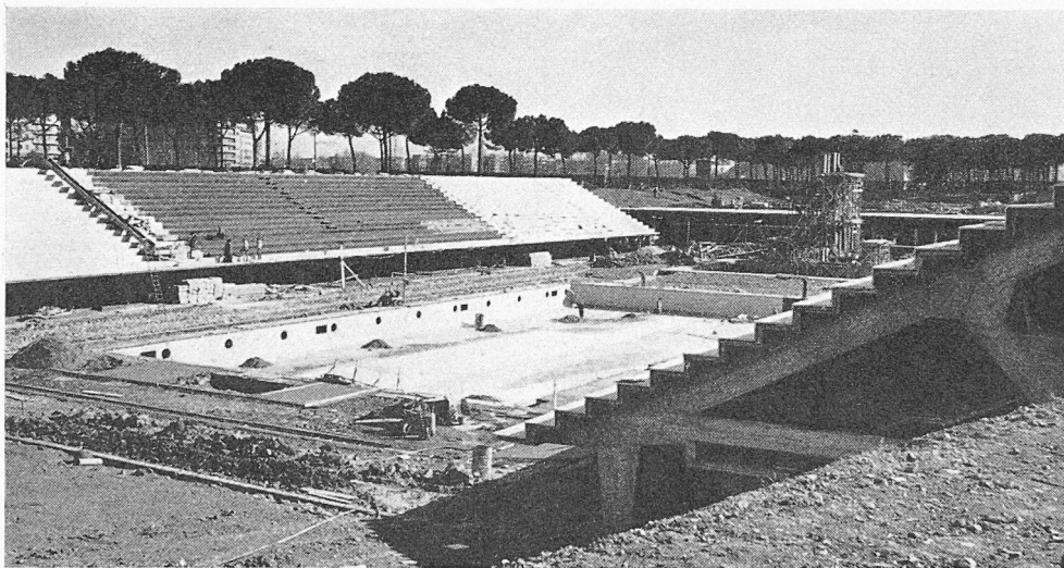
Bild 11. Zuschauertribüne des Schwimmstadions, mit Travertinplatten verkleidete Eisenbetonkonstruktion
