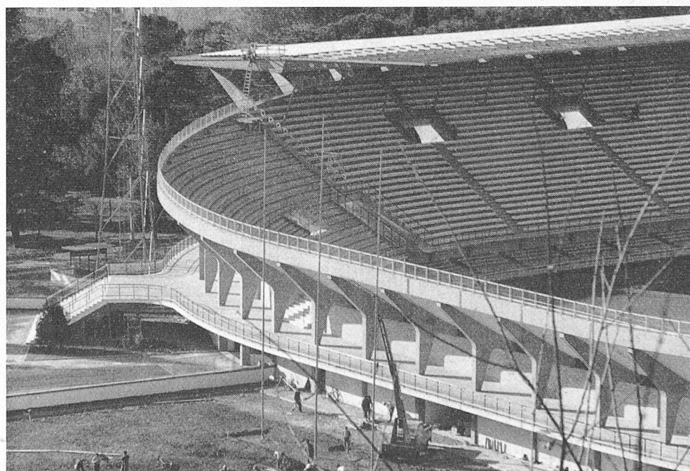
Bild 9. Stadio Flaminio, Haupteingang und Rahmenkonstruktion, 15 m auskragendes Tribünendach
