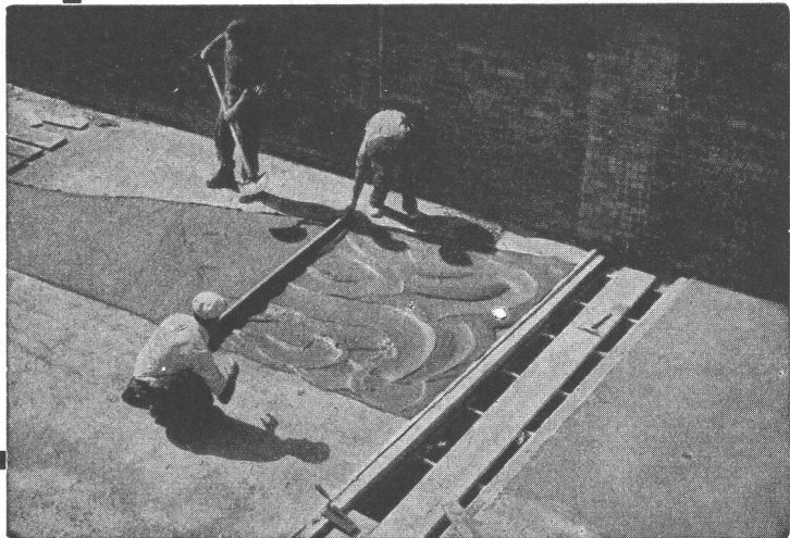
Flachdach zweischichtig, begehbar
