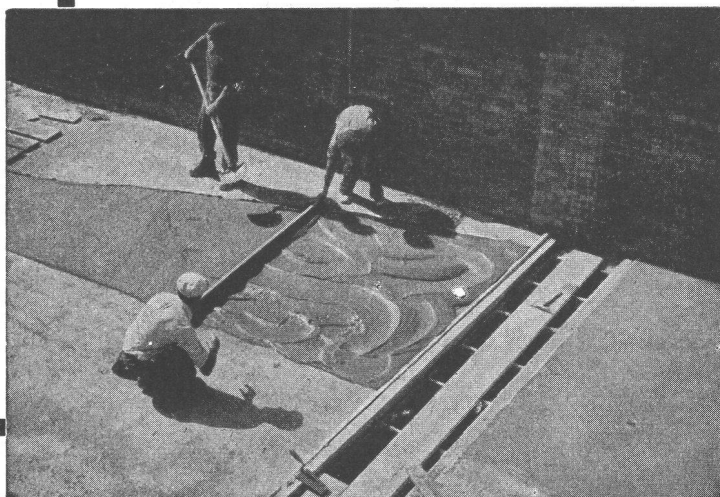
Flachdach zweischichtig, begebar
