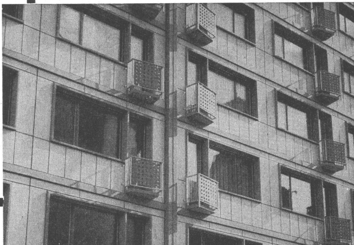
Ausfächung eines Beton-Skelettbauwerks
