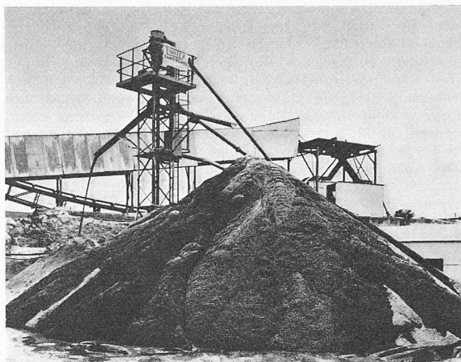
Bild 9. Linatex-Sandabschneider, Leistung 4 bis 46 m 3 /h
