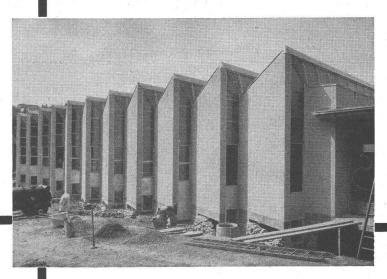
Eisenbetonbau, vollständig mit PORA-Platten ummantelt
