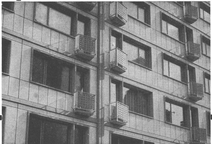
Ausföchung eines Beton-Skelettbau
