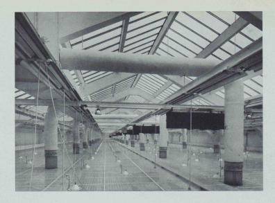
Dachraum mit Beleuchtungs- und Belüftungs-Installation; unten Ausstellungssaal
