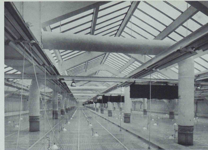
Dachraum mit Beleuchtungs- und Belüftungs-Installation; unten Ausstellungssaal
