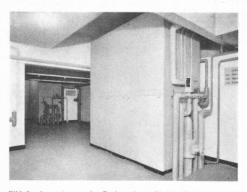
Bild 9. Apparateraum im Dachgeschoss, Rechts eines der beiden Klimaaggregate für den Ausstellungssaal; vom zweiten sieht man ganz links einen kleinen Teil
