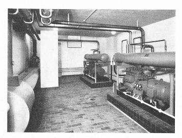
Bild 8. Kältezentrale. Rechts die beiden Maschinengruppen mit den darüber gebauten Kondensatoren; links der Wasserkühler. Die Kaltwasser-Umwälzpumpen sind durch den Pfeiler verdeckt
