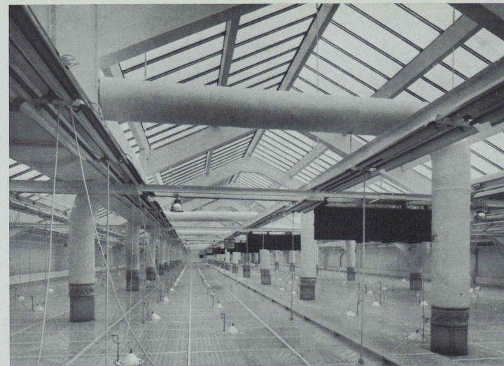
Dachraum mit Beleuchtungs- und Belüftungs-Installation; unten Ausstellungssaal
