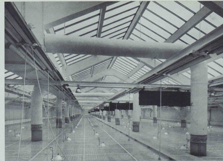
Dachraum mit Beleuchtungs- und Belüftungs-Installation; unten Ausstellungssaal
