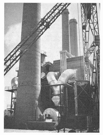
Bild 1 Zementfabrik Tourah, Entstaubungs-Anlage Ofen 3
