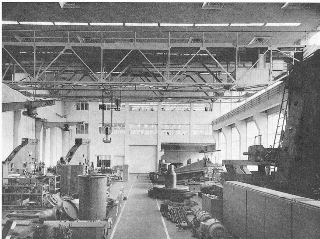
Bild 2. Innenansicht der Halle; hinten die Zugänge (Schleusen), darüber die Konstruktionsbüros; an der Decke die Anemostaten für die Zuluft
