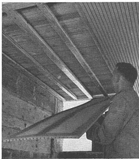
Holzfaserplatten werden mit Brigatex P durch blosses Anklopfen sogar auf Beton verleimt
