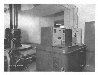
Bild 2. Elektrischer Turbinenregler in der Zentrale Fionnay (Mauvoisin). Rechts der Apparatekasten mit den verschiedenen elektrischen Kreisen, in der Mitte das Steuerwerk und links das Wellenende und der Leitapparat der Turbine
