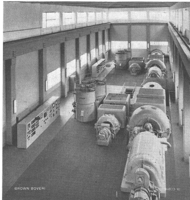
Bild 1. Die Gasturbinenzentrale in Livorno (Italien). Die beiden 25-MW-Gasturbinengruppen liefern die Energie in das Ueberlandnetz der Toscana. Der thermische Klemmenwirkungsgrad beträgt rund 25 Prozent. Die Maschinen werden gewöhnlich in 18 bis 20 Minuten auf Vollast gebracht. Dieser Maschinentyp ist besonders für Spitzen- und Notstromzentralen geeignet.
