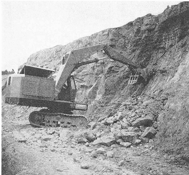
Bild 3. Abbau des Tonmergels mit hydraulischem Bagger
