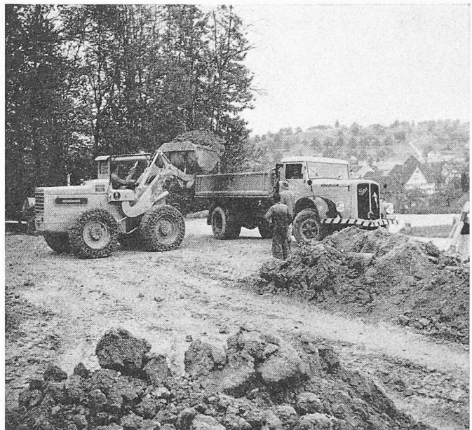
Bild 4. Beladen des Lastwagens mit Pneuladeschaufel
