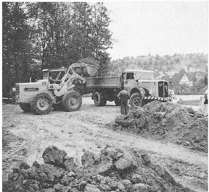
Bild 4. Beladen des Lastwagens mit Pneuladeschaufel
