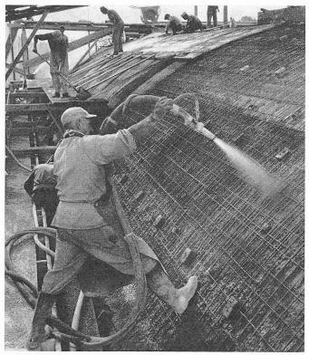
Bild 7. Ausführung der 7 cm starken Schalen im Spritzverfahren.
