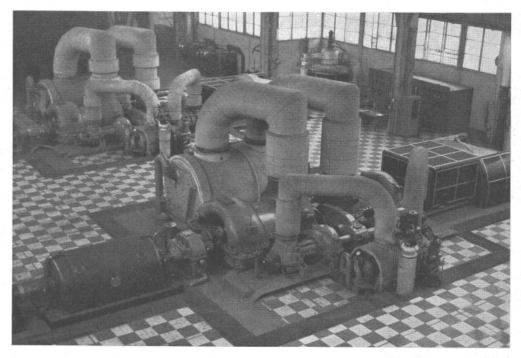
Das Bild zeigt zwei Sulzer-Gasturbinengruppen von je 7500 kW, die im Werk Couillet der Société Métallurgique Hainaut-Sambre (Belgien) aufgestellt sind. Sie dienen zum Antrieb elektrischer Generatoren und Hochofengebläsen und haben rund 28 000 Betriebsstunden hinter sich. Bei den im Jahre 1957 von einer neutralen Expertenkommission durchgeführten Abnahmemessungen wurden folgende Leistungen und Wirkungsgrade gemessen (in Klammern = Garantiewerte):
