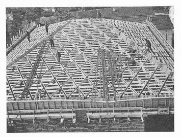
Die Eisenbeton-Rippendecke wird armiert (Aufnahme des Unternehmers A. Piatti, Dietlikon ZH)
