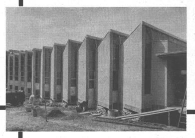
Eisenbetonbau, vollständig mit PORA-Platten ummantelt
