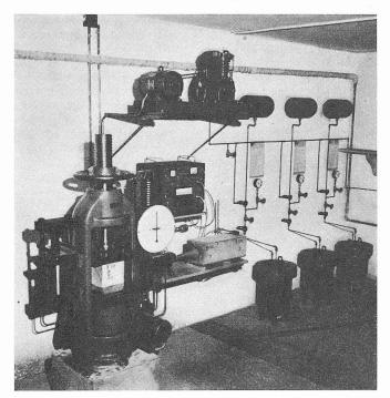
Bild 12. Prüfgeräte für erhärteten Beton, Links: 200-t-Presse für Würfel 20/20/20 cm, rechts daneben Schallmessgerät zur zerstörungsfreien Prüfung der Auflockerung des Gefüges von Prismen 20/20/60 cm infolge Frosteinflüssen. Rechts am Boden: Druckgefässe zur Prüfung der Wasserdichtigkeit von Betonwürfeln 20/20/20 cm
