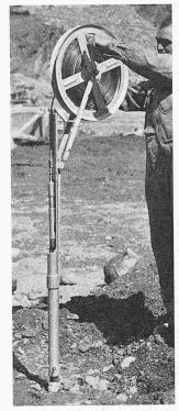
Bild 12. Auf dem Setzungspegel aufgesetzte Messeinrichtung. (Photo Brügger)
