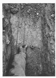
Bild 5. Piezometerdruckzelle vor dem Einbau in der Kernzone.
