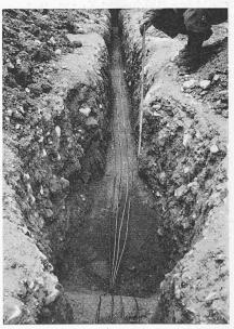
Bild 8. Im Graben verlegte Kupferröhrchen der Piezometerdruckzellen.
