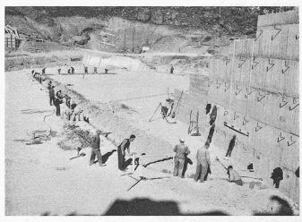
Bild 6. Oeffnen der Gräben in der Kernzone für den Einbau der Piezometerdruckzellen.
