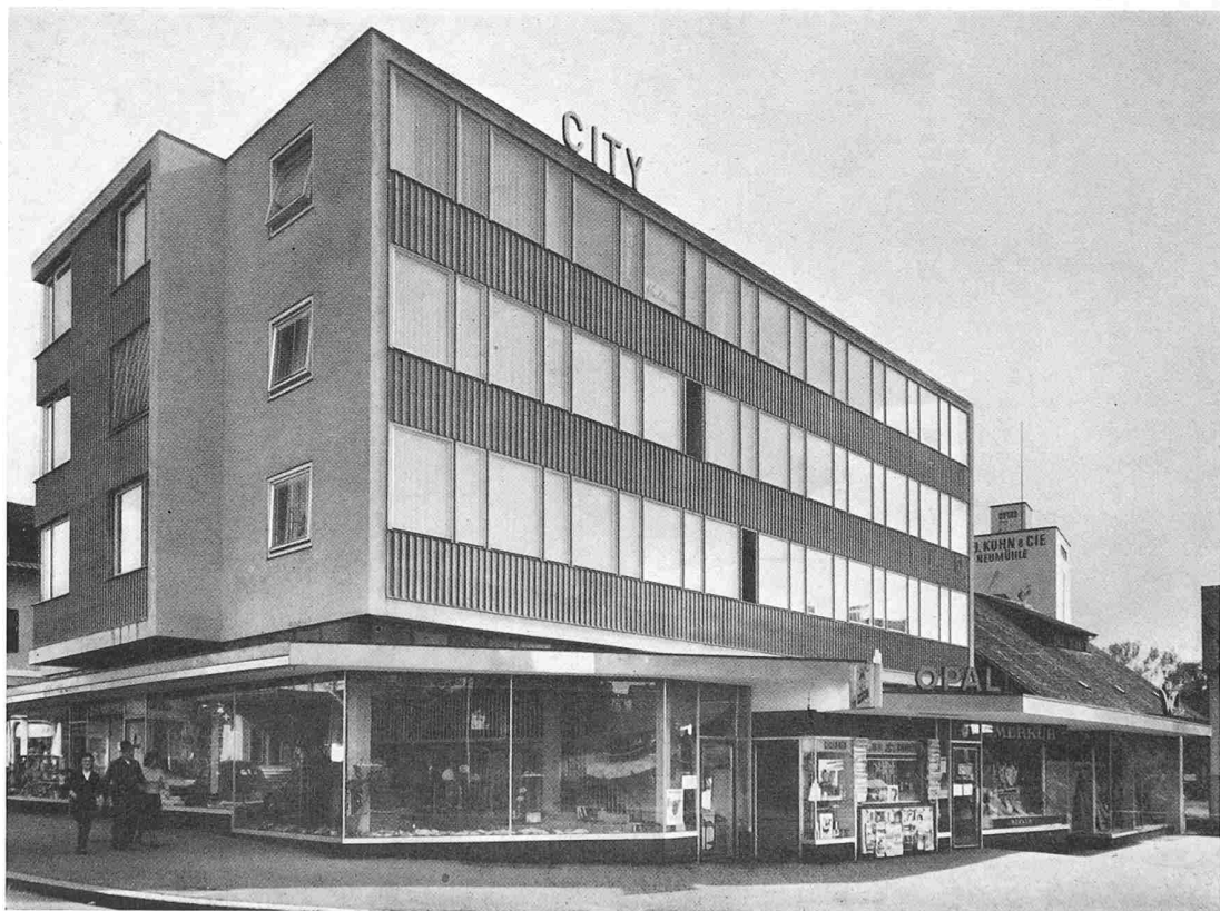
Ansicht aus Nordwesten
