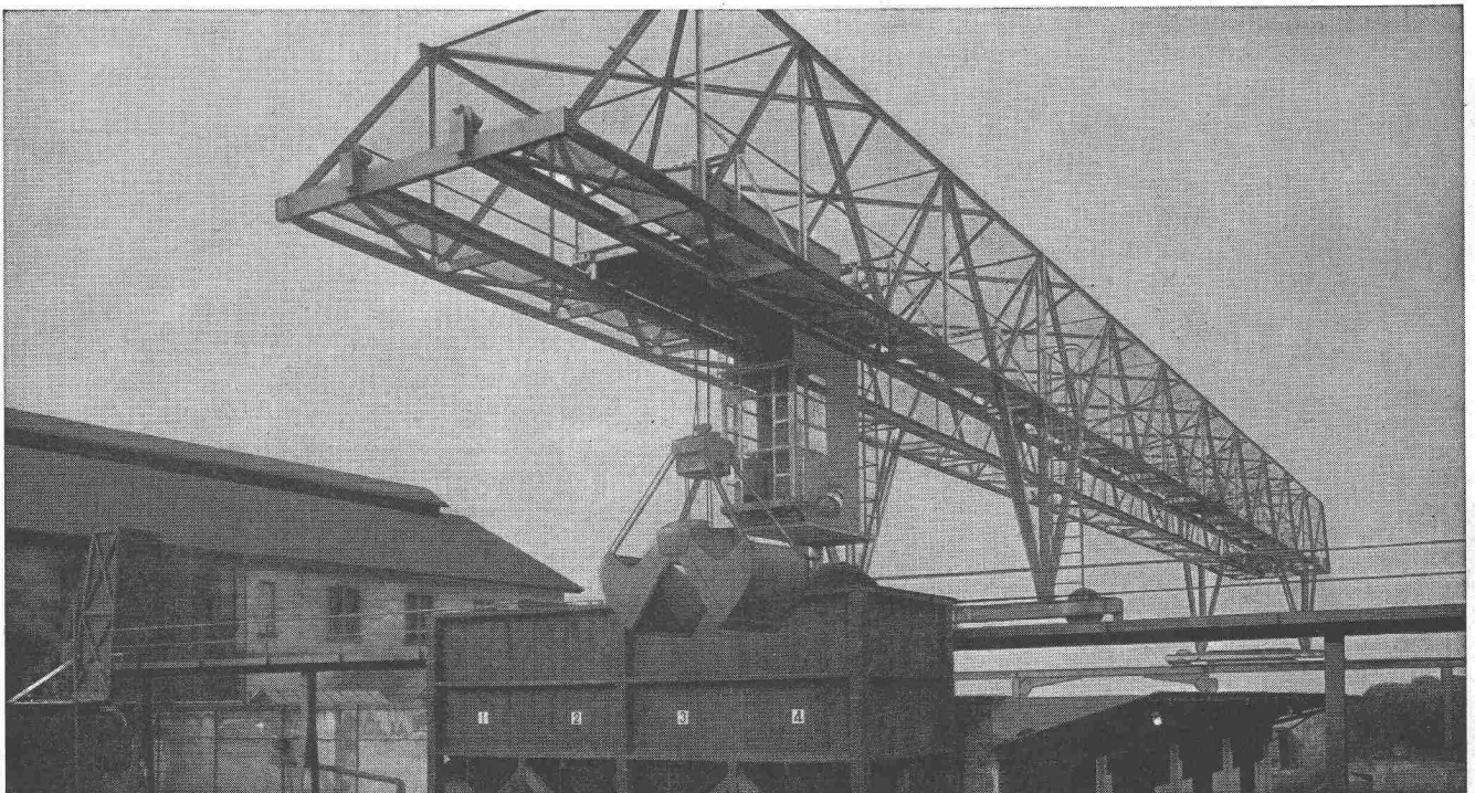
Verladebrücke in Schweisskonstruktion 2,5 t Tragkraft, 46 m Länge
