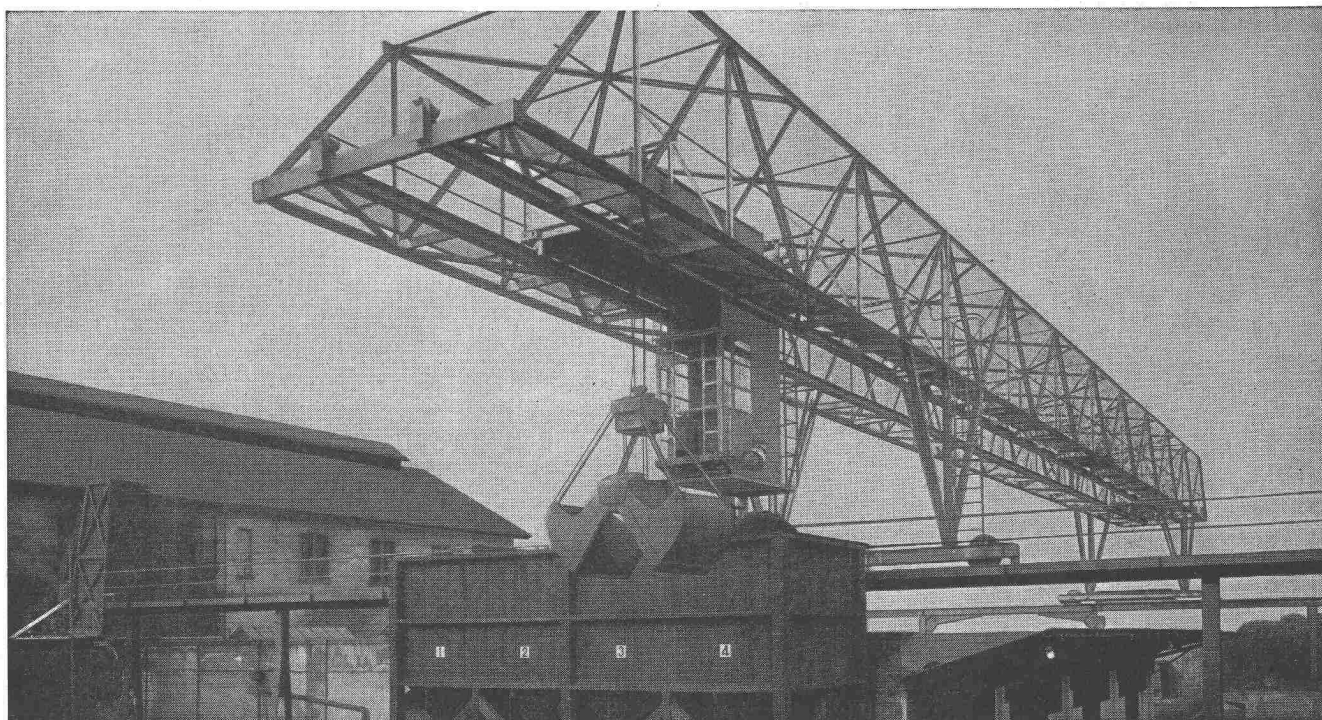
Verladebrücke in Schweisskonstruktion 2,5 t Tragkraft, 46 m Länge
