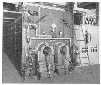
Bild 3. Ansicht des Dreizug-Siederohrkessels mit Wasserrohr-Vorkessel in der Schweiz. Bindfadenfabrik Flurlingen
