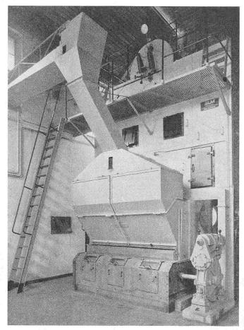
Bild 5. SLM-Wasserrohr-Strahlungskessel in einem Fabrikationsbetrieb des Bundes
