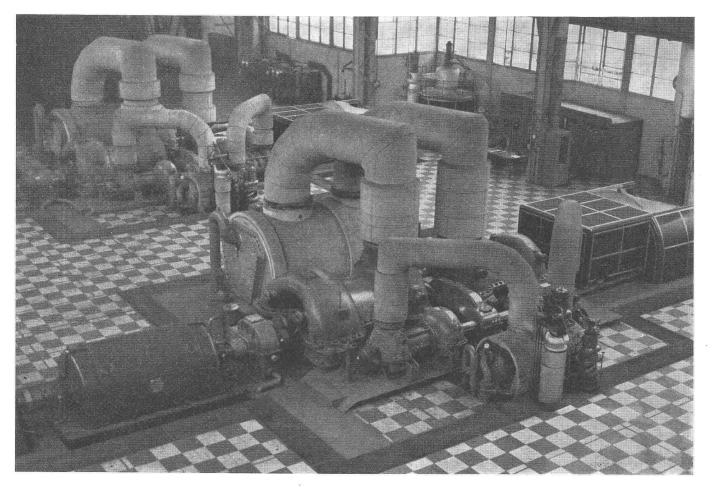
Das Bild zeigt zwei Sulzer-Gasturbinengruppen von je 7500 kW, die im Werk Couillet der Société Métallurgique Hainaut-Sambre (Belgien) aufgestellt sind. Sie dienen zum Antrieb elektrischer Generatoren und Hochofengebläsen und haben rund 28 000 Betriebsstunden hinter sich. Bei den im Jahre 1957 von einer neutralen Expertenkommission durchgeführten Abnahmemessungen wurden folgende Leistungen und Wirkungsgrade gemessen (in Klammern = Garantiewerte):
