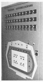
Bild 10. Schalttafel-Steuerfeld mit Blindschema
