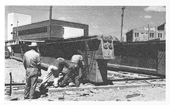
Bild 8a. Querverschieben zum Gleis mit Rätschenflaschenzügen. Als Unterlage für die Gleitschiene und zur Aufnahme des Auflagerdruckes nach dem Vorspannen ist an den Trägerenden ein Fundamentstreifen aus Beton hergerichtet worden. Die Schalung ruhte dazwischen nur auf einem Holzschwellenrost, mit dem auch die Bodenunebenheiten ausgeglichen wurden
