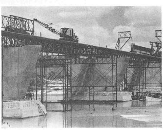
Bild 8f. Umsetzen der Montagerahmen mit Pneukran: Teile des Riegels werden vom Kran herangezogen. Im Hintergrund die montierten Stiele und ein Einhängeträger unterwegs
