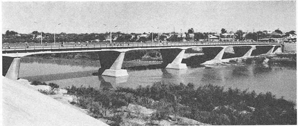
Bild 1. Die neue Brücke, Blick auf das amerikanische Ufer
