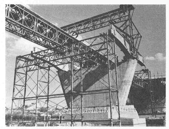
Bild 8e. Zwei Randträger sind versetzt, Grundsätzlich ist die Montage der Kragträger gleich wie die der Einhängeträger
