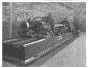
Walzenschleifmaschine auf isoliertem Fundament
