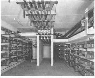
Bild 19. Abgang der Schienensysteme aus der Schaltanlage in die Schienenkanäle. Links und rechts die begehbaren Schienenkanäle; in der Mitte die getrennt geführte Hochleistungsleitung; oben rechts Kühlwasserleitungen
