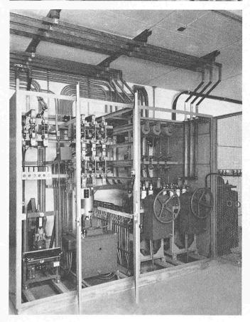
können auch parallel zueinander als Motoren bzw. als Generatoren laufen, oder die Gruppe kann bei ausgerückter Kupplung als Ward-Leonard-Gruppe benützt werden, wobei der Generator Frequenzen bis 60 Hz erzeugt. Diese Maschinengruppe kommt bei der nächsten Ausbauetappe zur Aufstellung.
