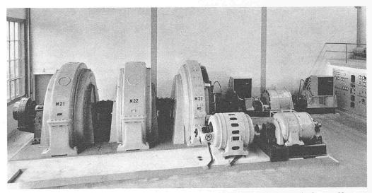
Bild 13. Gruppe  $M_2$  von 2,8 MVA, rechts hinten die Mittelfrequenzgruppe  $M_4$ , davor die Gruppe  $M_3$ , ganz rechts ein Teil der Steuerschalttafel
