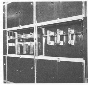
Bild 21. Zwei Schaltzellen des Hauptlinienwählers mit geöffneten Türen
