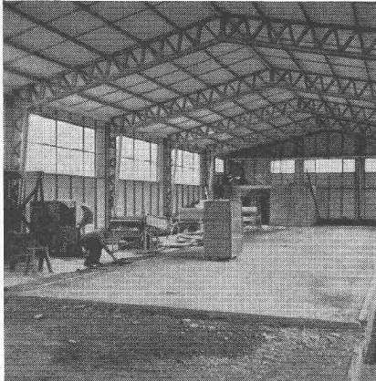
Die neue Fabrikhalle der Int. Verbandstoff-Fabrik Neuhausen a. Rheinflall
