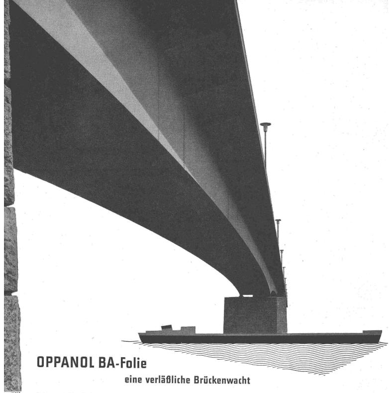
Sicker- und Oberflächenwasser sind die Feinde der Brückenkonstruktion. Mit harmlosen Korrosionsschäden beginnt es, am Ende stehen kostspielige Reparaturen. Als wirksamer Schutz gegen Feuchtigkeitsschäden bei Bauwerken der verschiedensten Art hat sich OPPANOL BA-Folie erwiesen. Dafür sorgen folgende Eigenschaften dieses Isoliermaterials: Wasserundurchlässig und wasserunempfindlich, dehnungsfähig, druckfest, alterungsbeständig und verrottungsfest.
