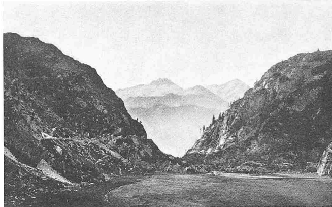
Bild 6. Emosson, Blick aus dem Stauraum auf die Sperrstelle.
