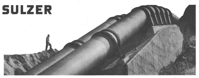
Fixpunktkonstruktion ohne Betonüberdeckung der Druckleitungen zur Zentrale Riddes-Mauvoisin
