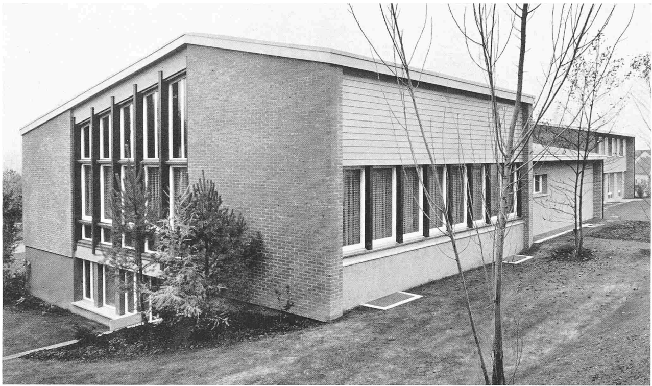
Ansicht aus Südwesten
