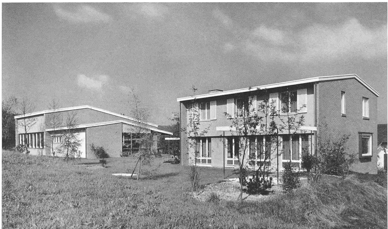
Ansicht aus Südosten
