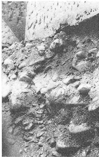
Bild 8. Aushubmaterial unter der Schneide des auf den Bildern 9 und 10 dargestellten Kastens
