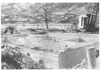
Bild 10. Der Kasten nach erfolgtem Absenken
