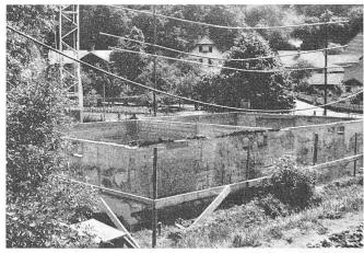
Bild 12. Fundation eines Gebäudes des Verbandes Schweiz. Konsumvereine in Gümligen. Absenken des Kellers in torfigem Untergrund ohne Spundung, mit Wasserspiegelabsenkung mittels einfachem Filterbrunnen. Der ganze Kellerteil wurde ohne Sohle fertig betoniert und dann als Monolith um etwa 4 m abgesenkt. Abmessungen  $22\,\mathrm{m}\times12\,\mathrm{m}\times5$  m. Bauunternehmung: AG. für Grundwasserbauten, Bern; Bauleitung: Ingenieurbureau Prantl und Gaschen, Thun
